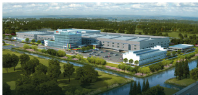
Der Bau der neuen Produktionsplattform in Nantong (China) verläuft nach Plan.
